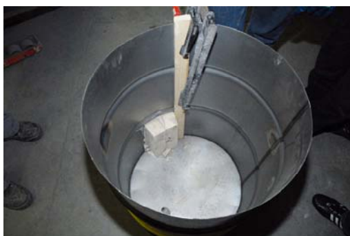
Das Ausmauern beginnt
